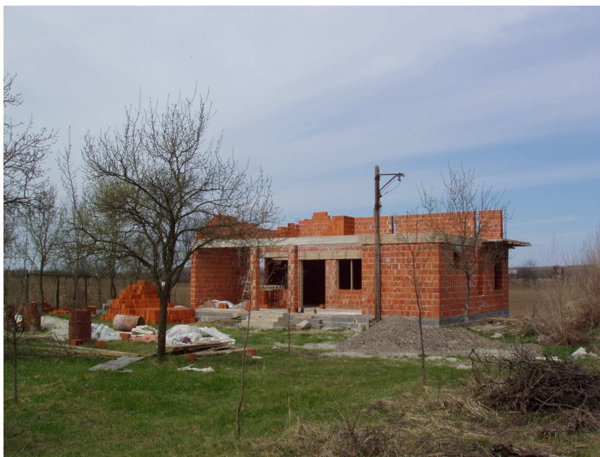
Lovački dom u izgradnji
