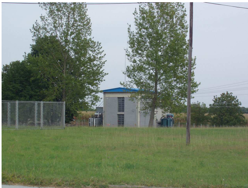
TS 35/10 kV Opatovac
