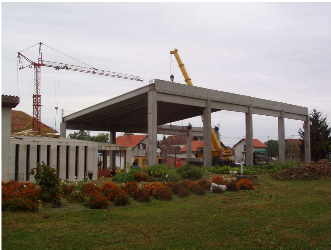
Školska-sportska dvorana u izgradnji
