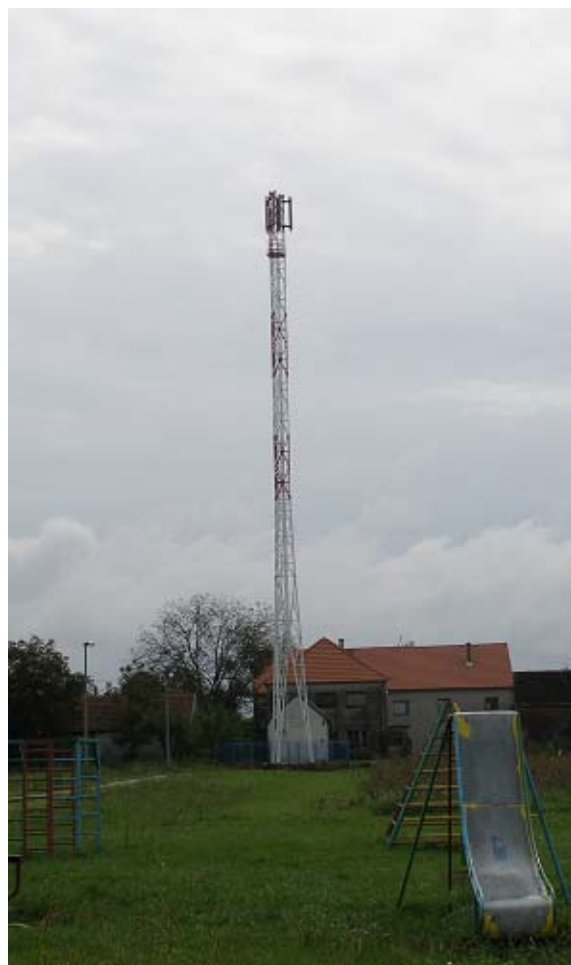
ANTENSKI STUP T - MOBILE IZA ZGRADE OPCINE PRIVLAKA
