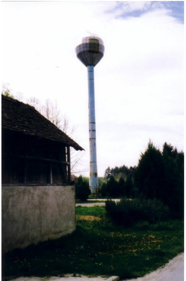
VISOKA VODOSPREMA U SKLOPU VODOCRPILISTA U VRBANJI
