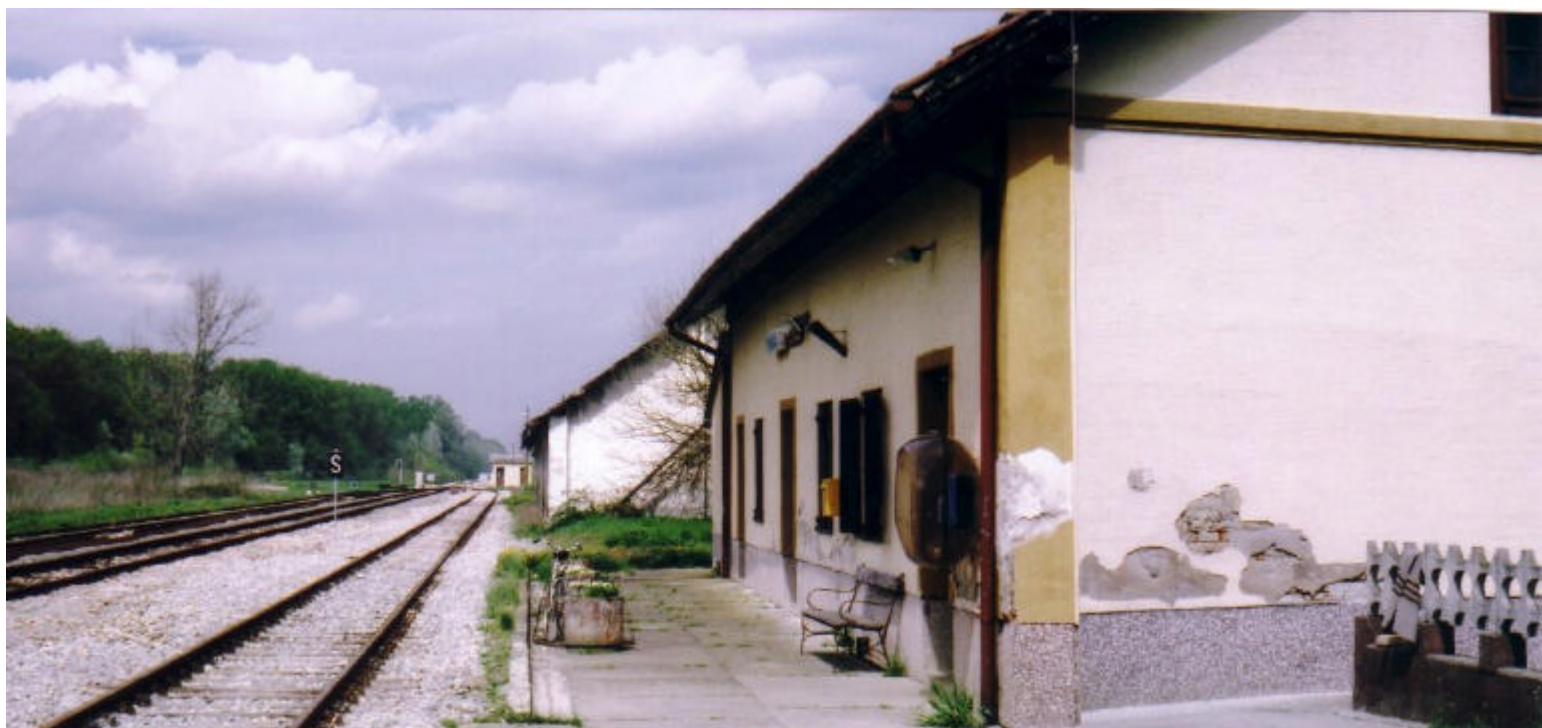
ŽELJEZNICKI KOLODVOR VRBANJA
