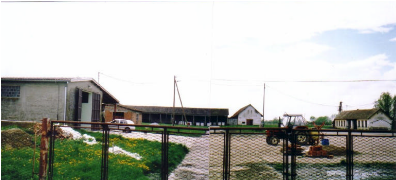
POSTOJEĆE GRAĐEVINE U PODUZETNICKOJ ZONI U SOLJANIMA
